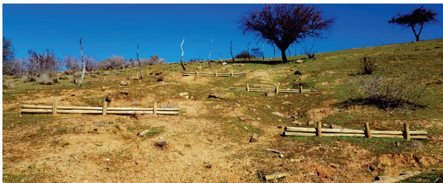
Figura 17. Técnica de empalizadas en cárcava que se está formando.
