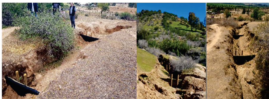
Figura 16. Diques en cárcava. Predio Sr. Hector Rojas. Peñablanca. Comuna de Pumanque.
