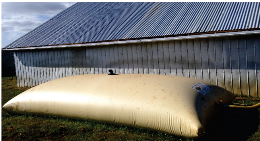
Figura 5. Cisterna flexible, como un sistema de acumulación de agua para uso agrícola o forestal.
