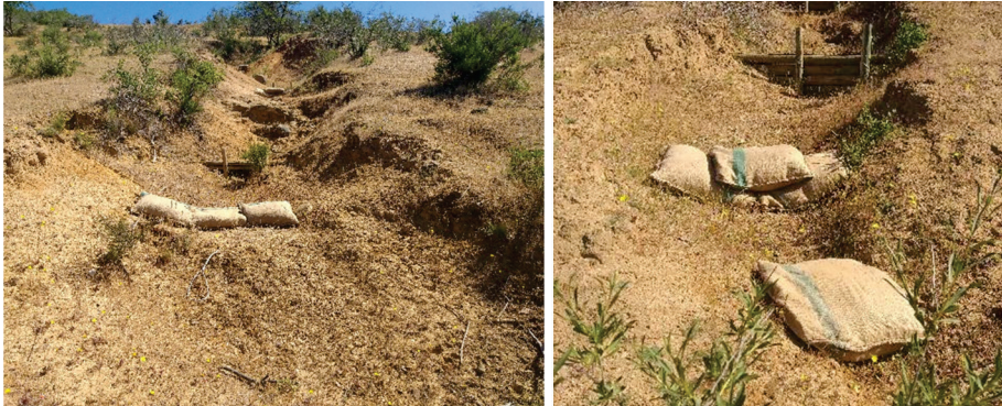
Figura 19. Uso de barreras de sacos con semillas de especies herbáceas y/o arbustivas en el inferior de la cárcava para disminuir velocidad del agua lluvia y comenzar a introducir cobertura vegetal.
