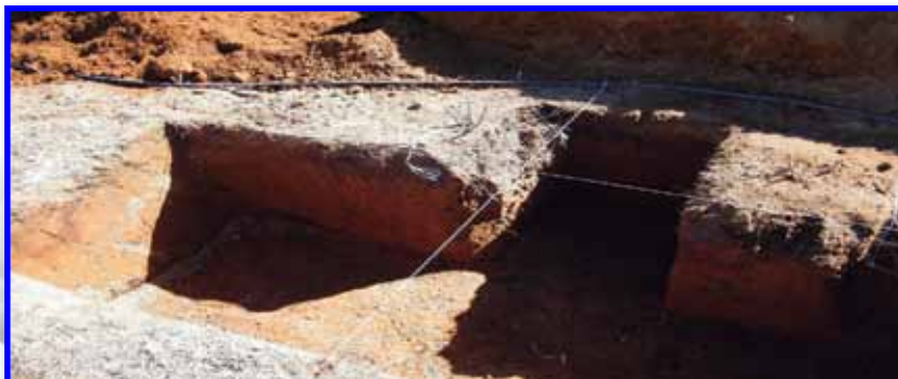
Foto 2. Construcción de calicata unidad en formación
