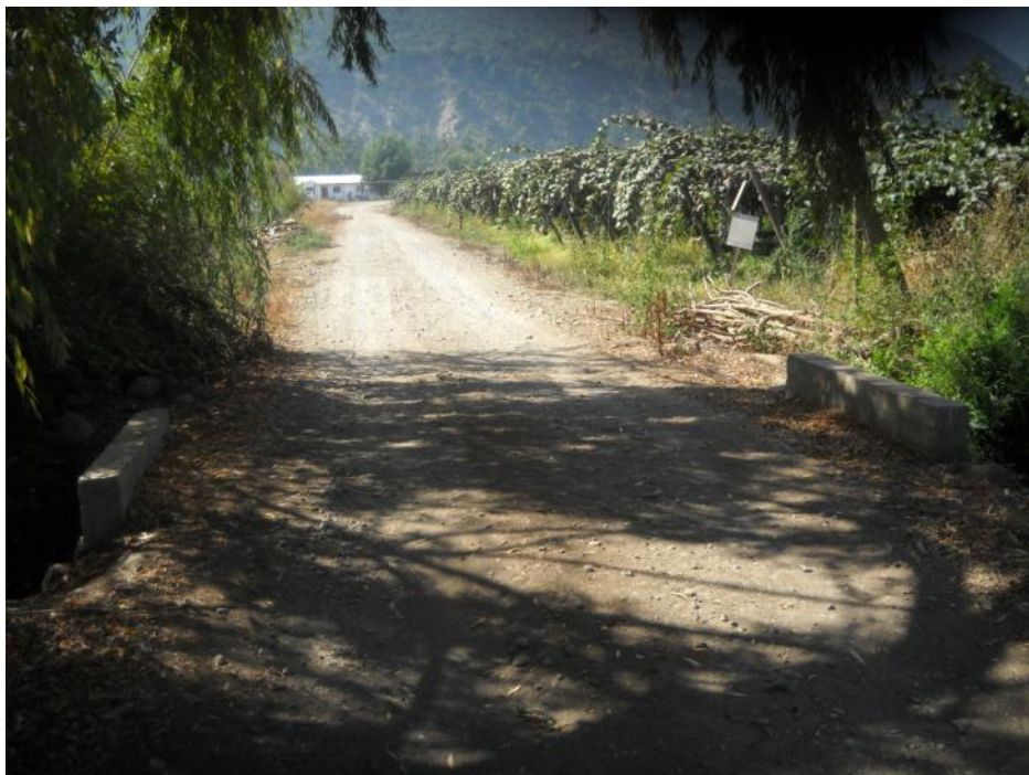
Foto 16: Cruce Alcantarilla Canal Popeta.
