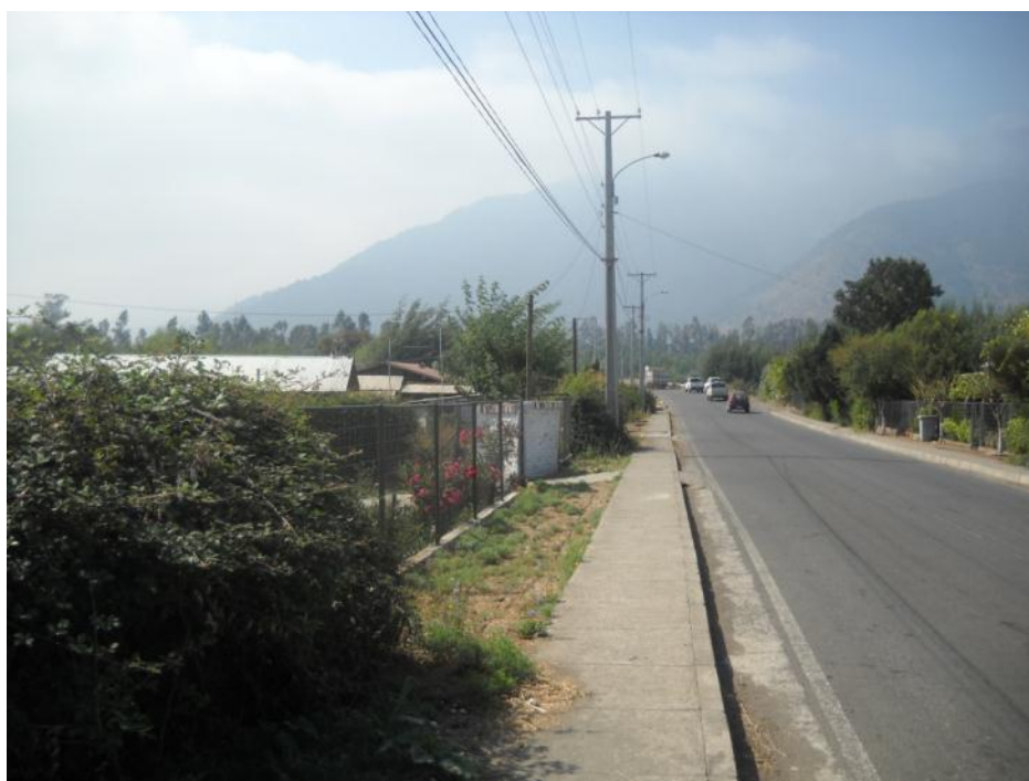
Foto 28: Viviendas cercanas a Sifón Cruce camino Canal Mira.
