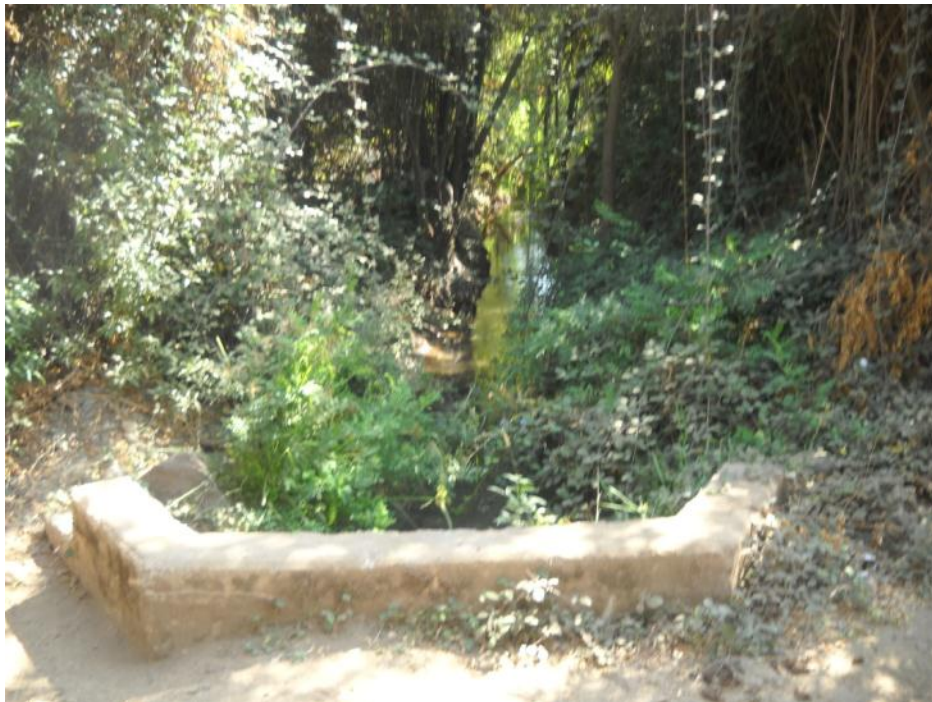
Foto 12: Cruce Canal Talhuén.
