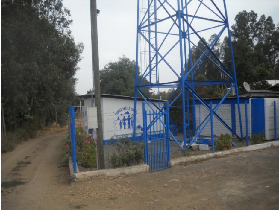
Foto 23: APR cercana a Canal Población Unificado.
