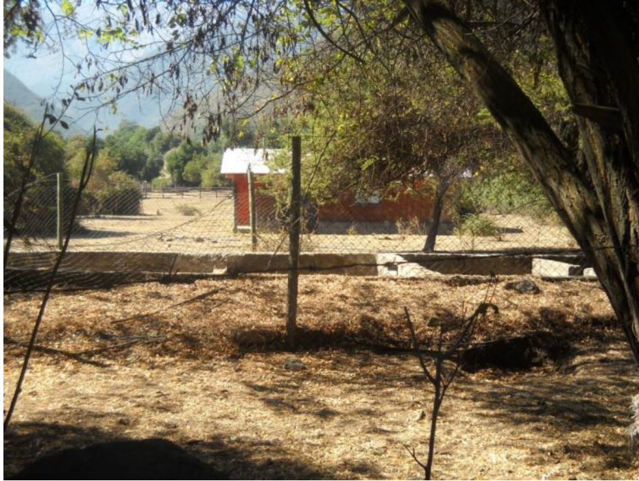
Foto 9: Vivienda en Bollenar Alto en zona de Inundación.
