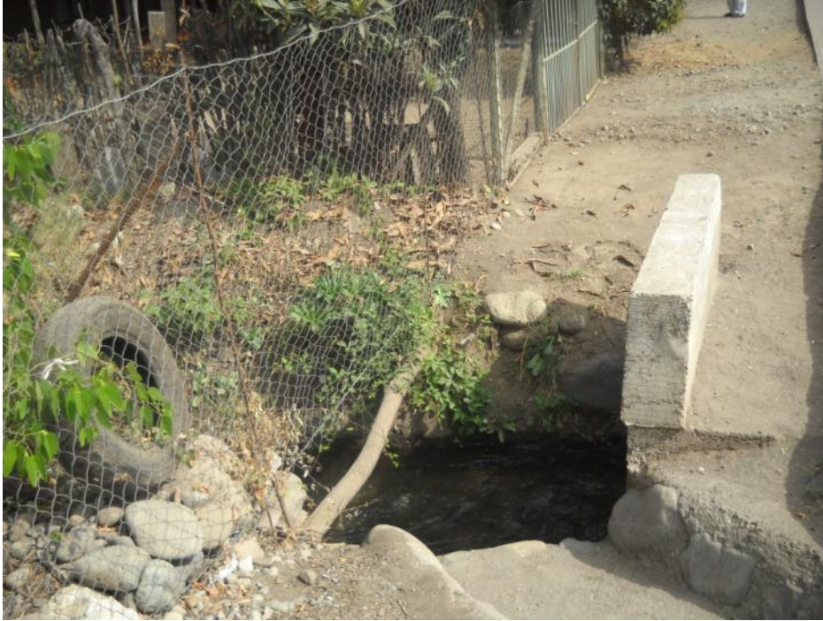
Foto 17: Cruce Canal Pedregal.
