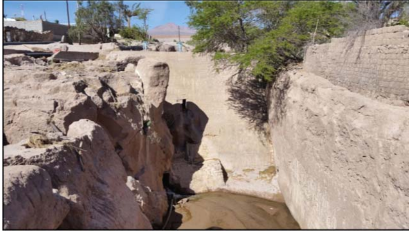
Figura 3-97 Tranque de Toconao en desuso
