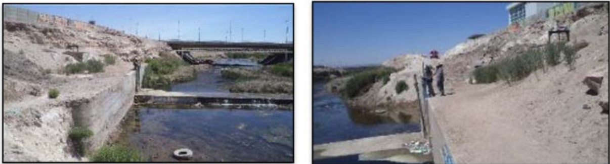
Figura 3-59 Canal y bocatoma Tronco
