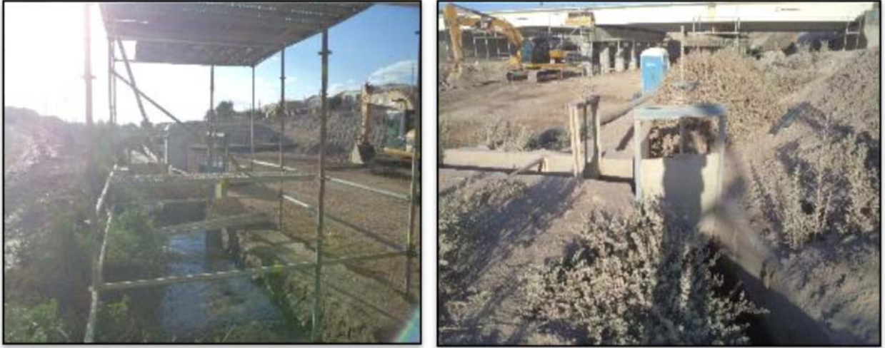
Figura 3-70 Bocatoma canal Núñez
