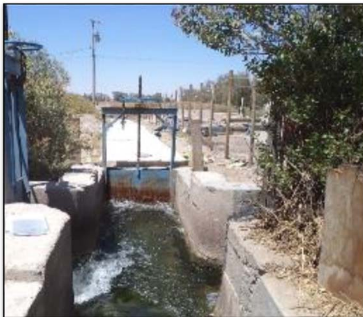
Figura 3-61 Bocatoma canal Bilbao
