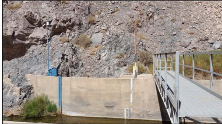
Figura 3-93 Estación fluviométrica a la salida del Tranque de Conchi
