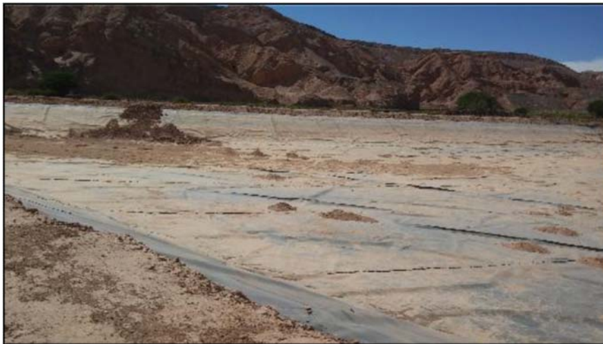
Figura 3-81 Estado actual tranque Guachar
