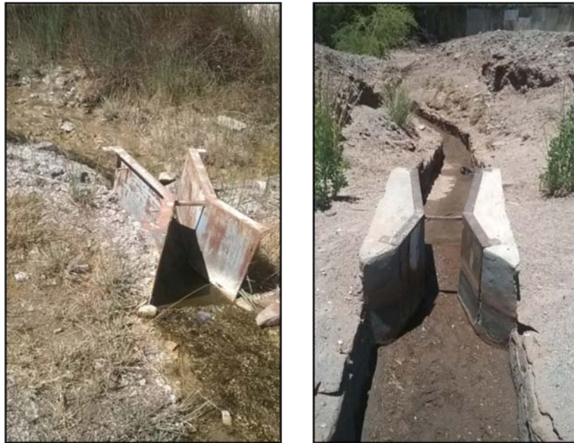
Figura 3-92 Aforadores Parshall
