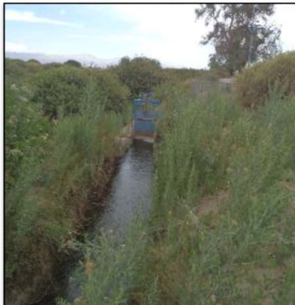
Figura 3-73 Bocatoma canal Lay Lay – La Banda
