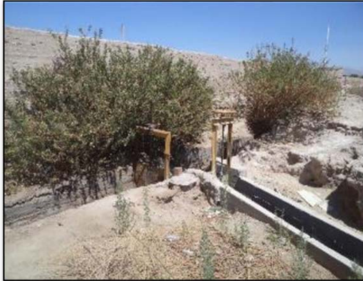
Figura 3-60 Bocatoma canal Tambores
