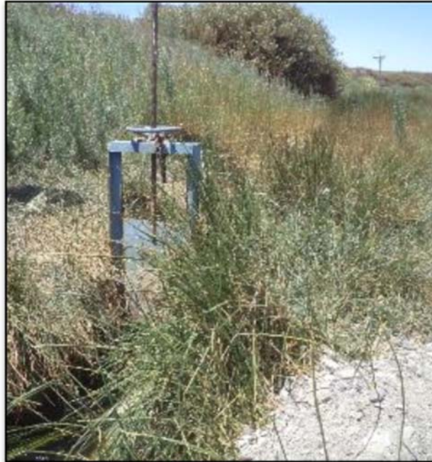
Figura 3-68 Bocatoma canal La Prensa
