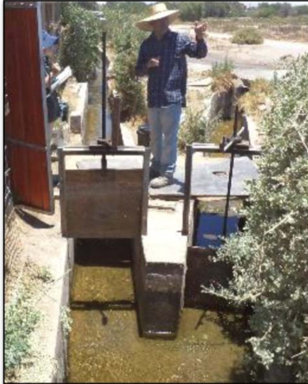
Figura 3-66 Bocatoma canal Chañar
