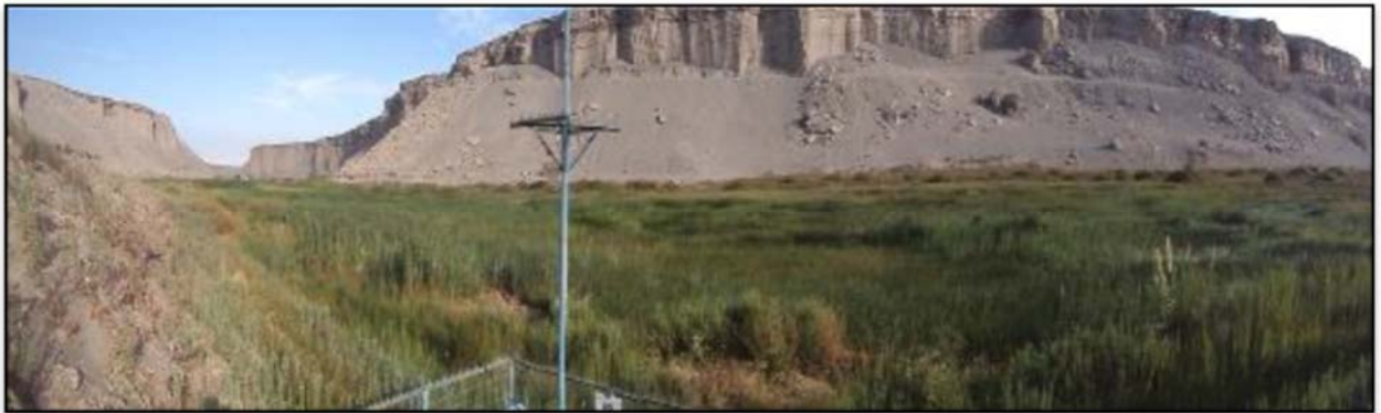
Figura 3-71 Bocatoma canal Yalquincha
