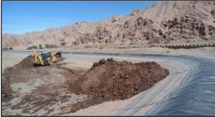
Figura 3-80 Tranque Guachar en operación, septiembre 2015
