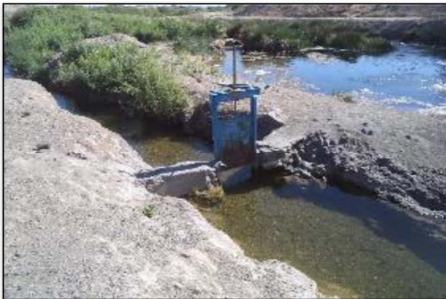
Figura 3-69 Bocatoma canal Topater
