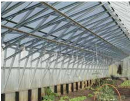
e) Invernadero de metal y policarbonato en la Región de Magallanes.
