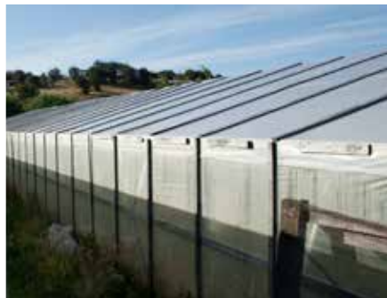
f) Vista exterior de invernadero de metal y policarbonato.
