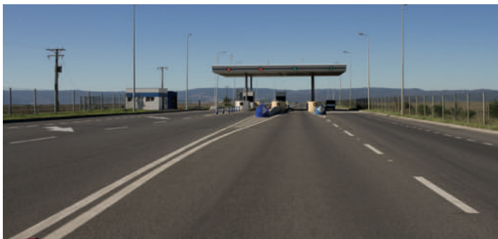
Descripción: Peaje enlace Rocuant, Ruta Interportuaria.
