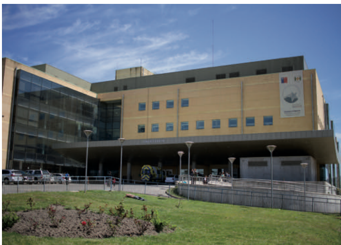
Descripción: Hospital de Alta Complejidad Las Higueras.
