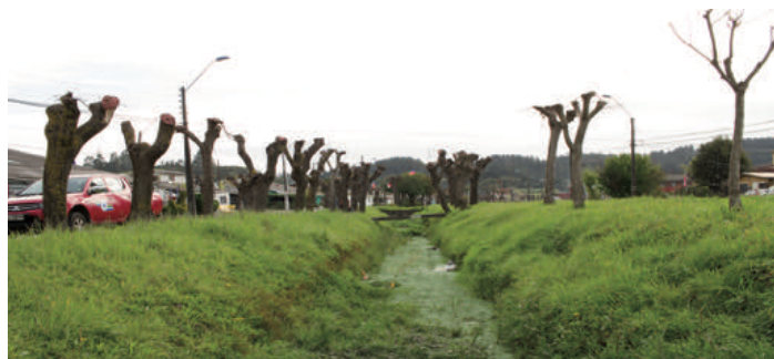
Descripción: Canal Obstruido por vegetación. Territorio Las Higueras.
