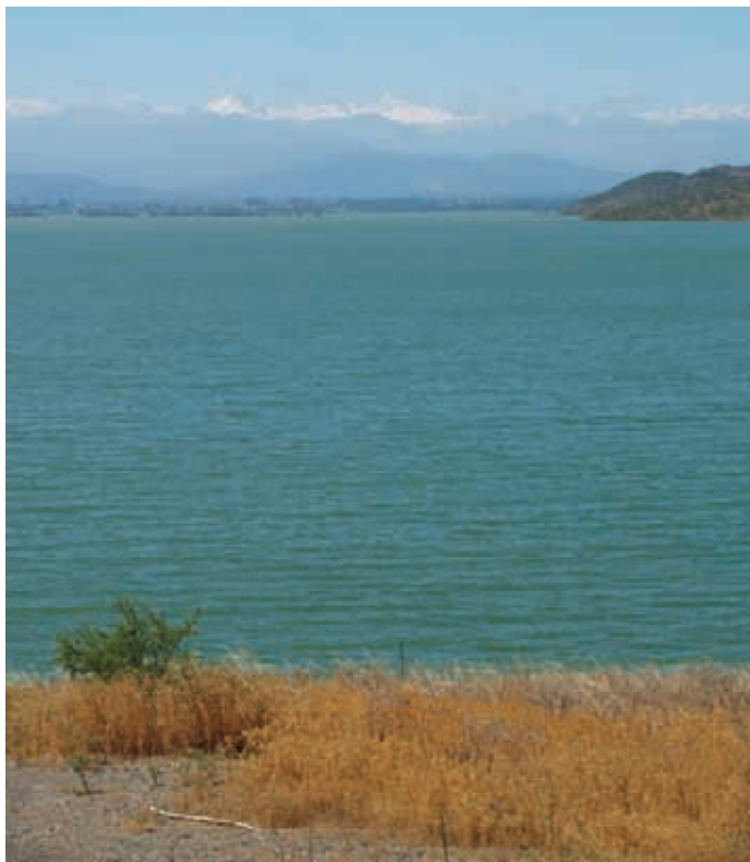
El Embalse Convento Viejo II Etapa tiene una capacidad de 237 millones de metros cúbicos. Este verano estuvo lleno.
