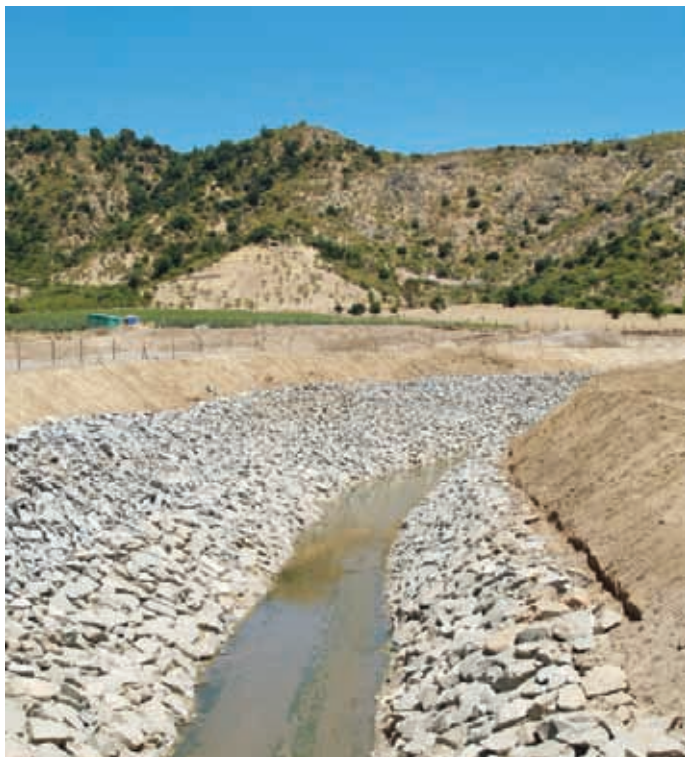
Tramo final del Canal Nilahue, de 12 kilómetros de largo.
