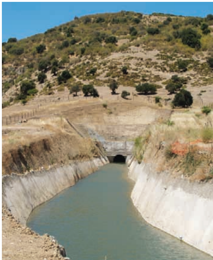
Salida del túnel La Lajuela hacia el sector del secano.
