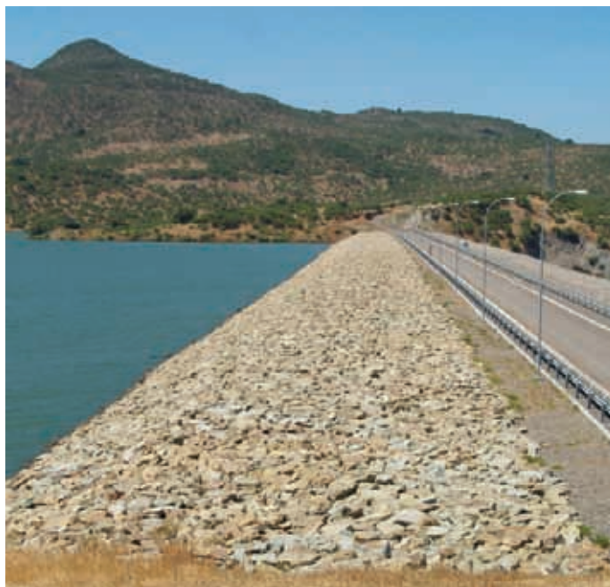
Presa principal. Se construyó con núcleo impermeable de material arcilloso y con una pared moldeada bajo el mismo, con un coronamiento de 674 metros de largo por 34 de ancho.
