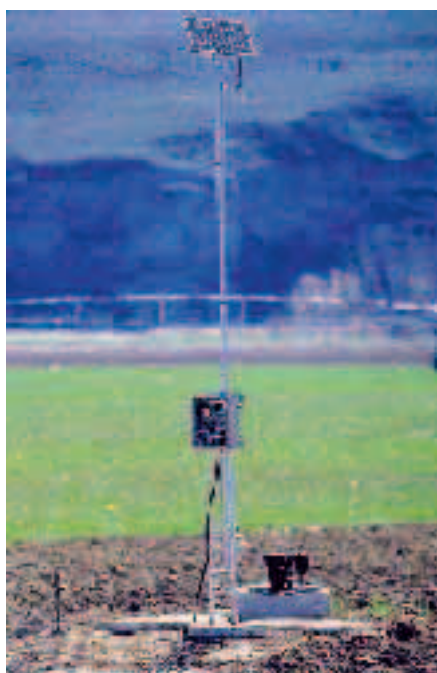
El sistema Iris opera a través de una red de estaciones concentradoras y cada una de ellas puede controlar hasta 255 tomas de agua.
