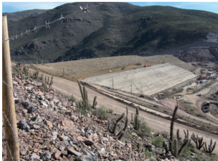
Construcción embalse El Bato en Illapel.
