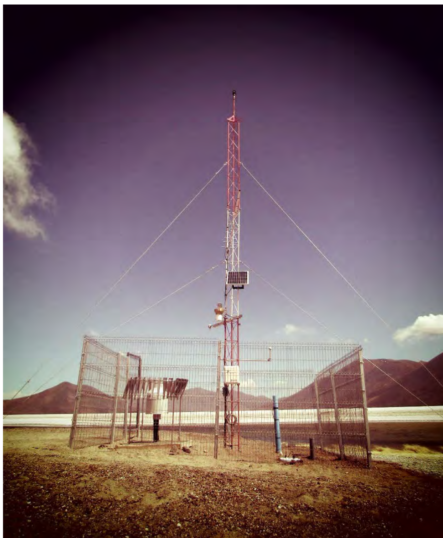
Figura 4-8: Estación Meteorológica instalada en el Salar de la Isla en la Fase 3.
