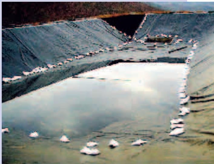
Los espesores de las geomembranas varían entre 0,5 mm y 5 mm, sin embargo para su uso agrícola se recomiendan las de 1 mm.
