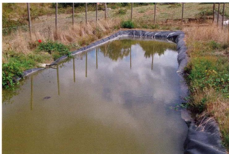
Figura 20. Acumulador con geo membrana.
