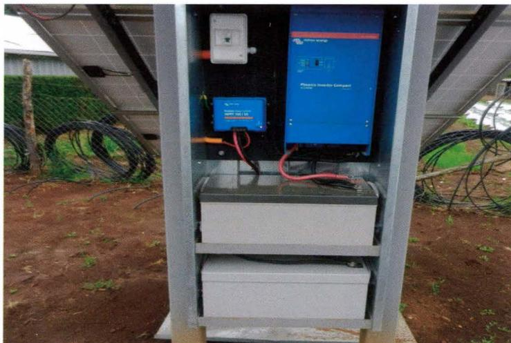
Figura 25. Sistema solar off grid.
