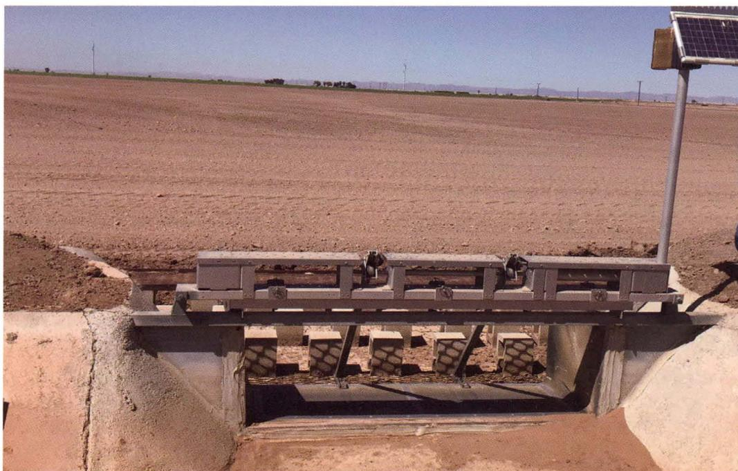
Figura 23. Compuerta eléctrica en sistema de riego superficial automático.
