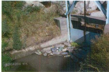
Foto dos: compuerta totalmente bloqueada por la basura (derivado sin agua)
