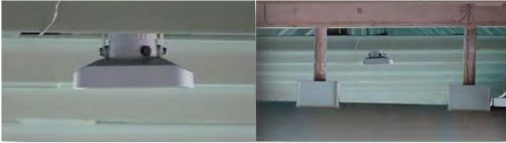
Figura 5.10. Radar RLS, anclado a la estructura metálica del puente.
