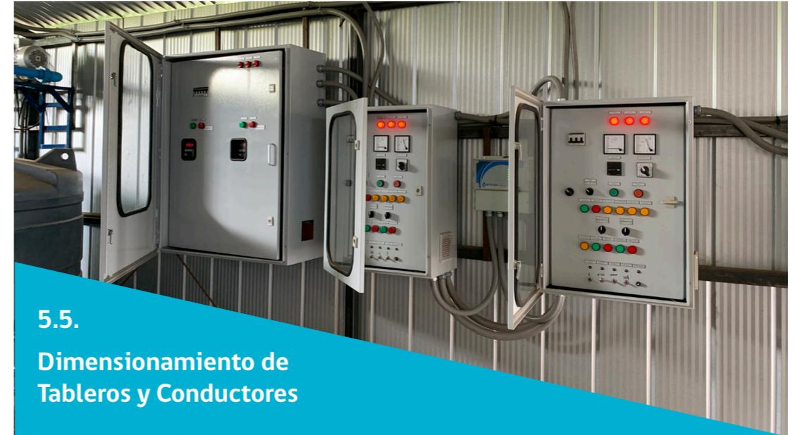
Un tema relevante en los sistemas de bombeo es la calidad y las capacidades de los componentes eléctricos que suministran la energía y potencia eléctricas. Cuando estas trabajan más allá de las condiciones normales de diseño, se requiere revisar estas instalaciones. La capacidad de transporte de un conductor se estima con la siguiente expresión:
