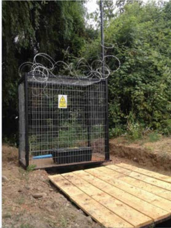
Estación telemetría Instalada en canal Purutún
