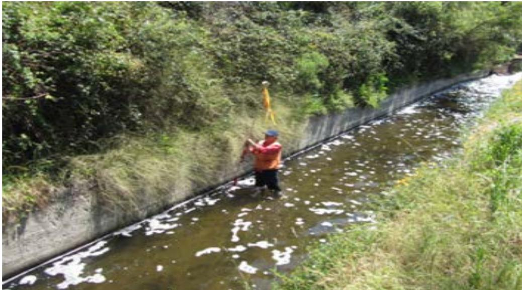
**Imagen: Zona elegida para desarrollar la sección de aforo Canal Mauco, aquí se construirá la grada solamente.-**
