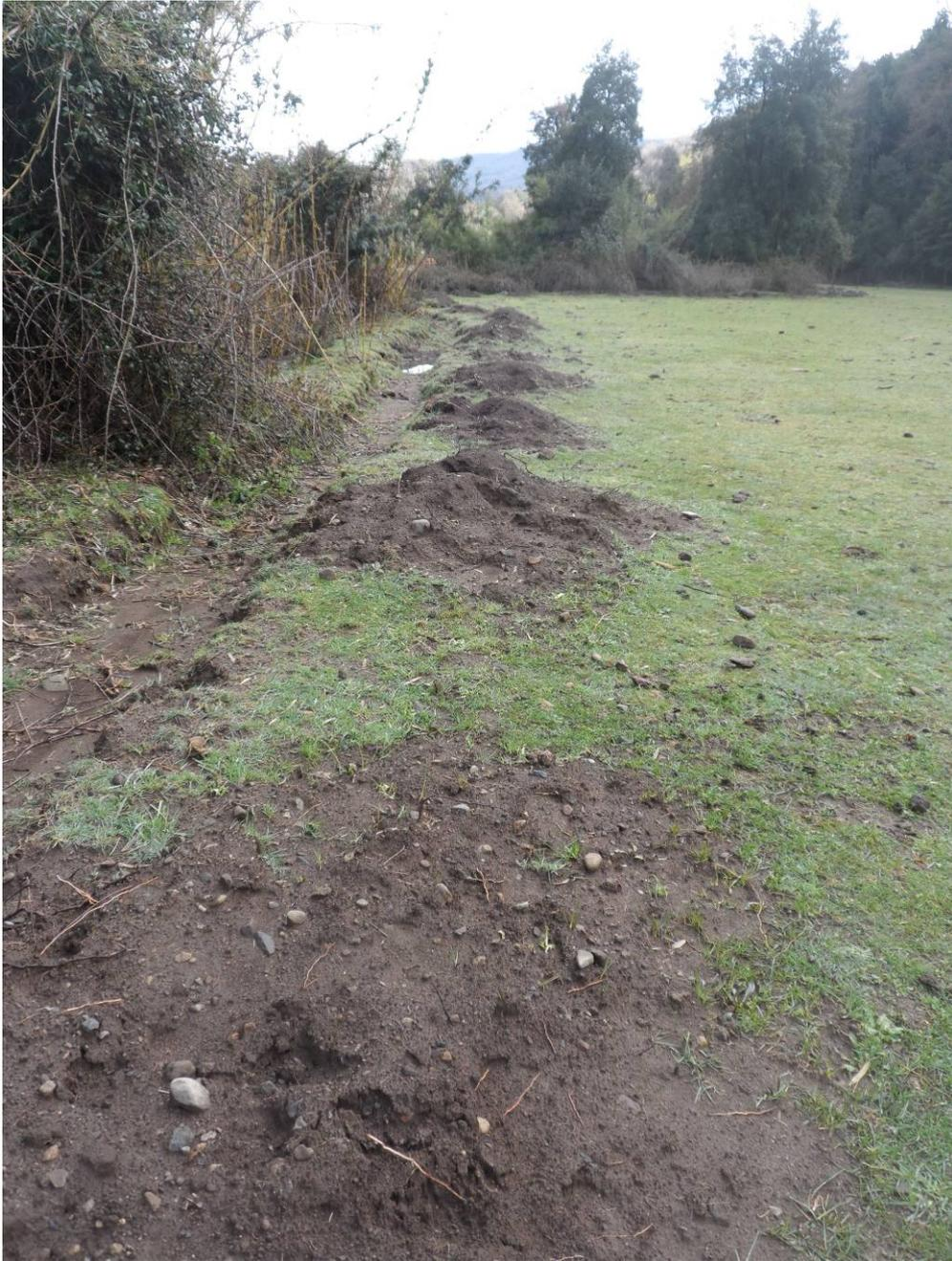
Figura 3. Excavación de acequias de drenaje (Foto 5 en Figura 2 del Apéndice 1).
