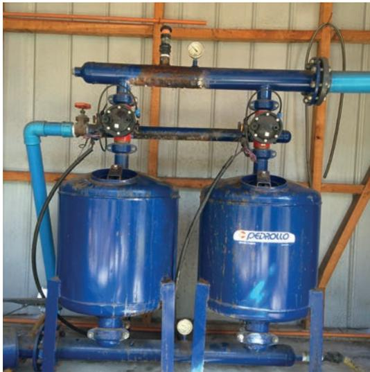
**Figura 4.4.** Manómetros controladores de presión de filtros en un método de riego presurizado.
