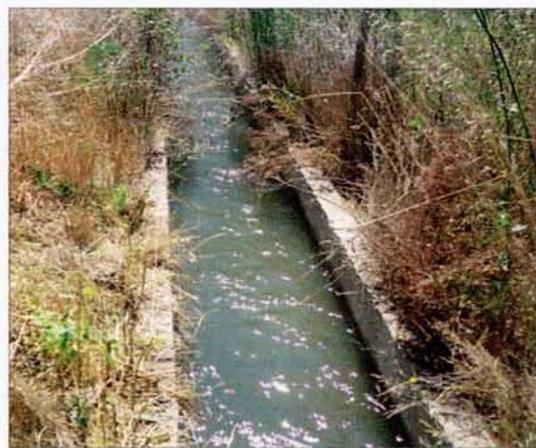
Recomendación técnica: implementar una sección de control, con un limnígrafo en algún tramo recto de canal que tenga condiciones adecuadas para el aforo, previamente es necesario reparar la compuerta.
