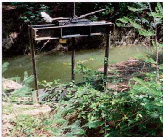
Recomendación técnica: implementar una sección de control, con un limnígrafo en algún tramo recto de canal que tenga condiciones adecuadas para el aforo.
