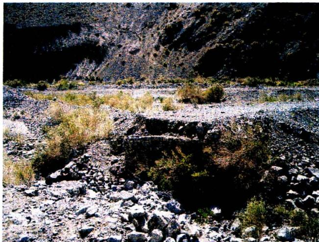
Figura 14. Puente cortado en la cuenca.
