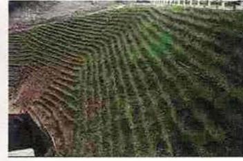
**Fotos 7, 8 y 9.** Control de taludes con barreras de Vetiver, dispuestas en curvas de nivel, usadas en redes viales de El Salvador y Malasia. Las barreras son establecidas de acuerdo al diseño y trazado de la Bioingeniería Vetiver, que considera parámetros, tales como: Características Edafoclimáticas del Sitio, Pendiente y Forma del Talud, Intervalo Vertical entre Barreras y Distancia entre Plantas
