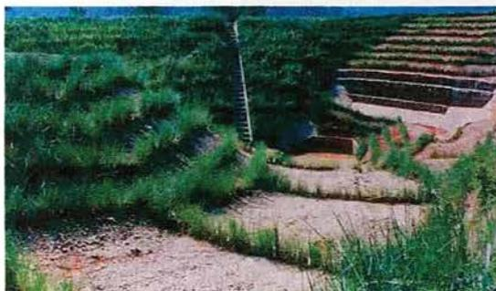
**Foto 13.** En el mismo sistema de la foto anterior, se observa otra funcionalidad interesante del Vetiver, relacionada con su capacidad de soportar inundaciones periódicas y de filtración de las aguas circulantes, en provecho de su facultad para retener material particulado, protegiendo así al colector de aguas lluvias y asegurando su funcionalidad por un periodo de tiempo mayor y a menores costos de mantención.
