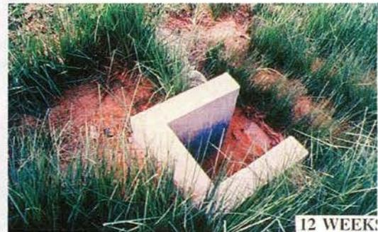
**Foto 14.** Sistema de desagüe en un talud. La disposición de las hileras de Vetiver es diferente en torno a la estructura y se adecúa a ella, según la orientación seguida por la circulación de las aguas. El principio básico de la Bioingeniería Vetiver es establecer siempre las barreras en la dirección perpendicular al flujo de agua, a fin de contener el escurrimiento y contrarrestar el proceso erosivo.
