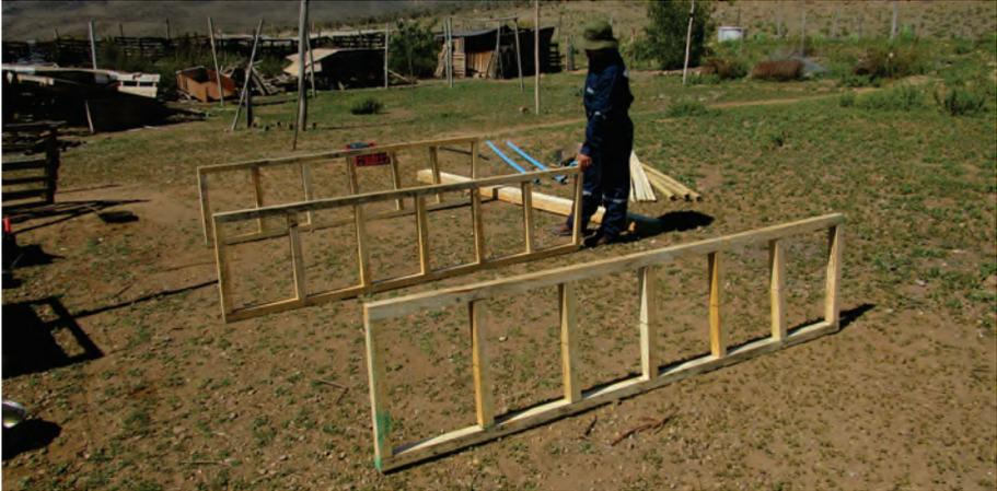
**Figura 18.** Bastidores armados y dispuestos en terreno para su unión.
