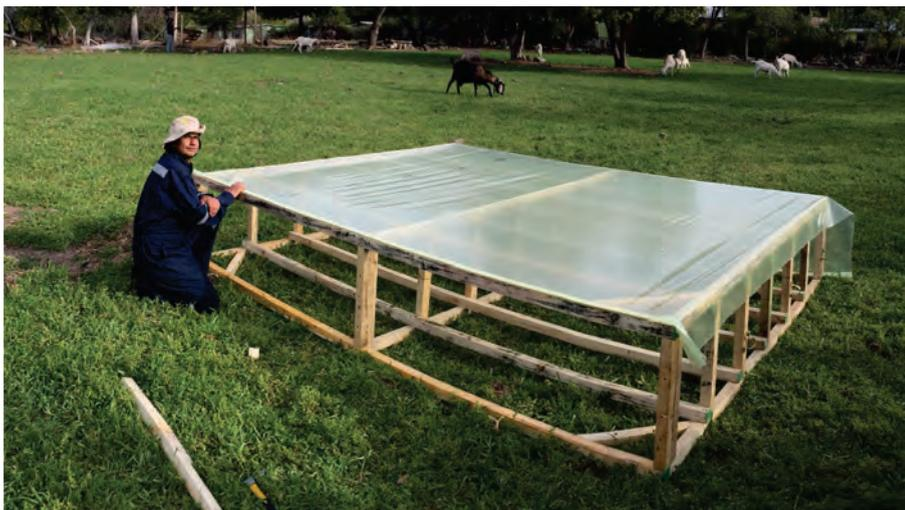
**Figura 20.** Módulo de producción en proceso de instalación de cobertura de polietileno.
