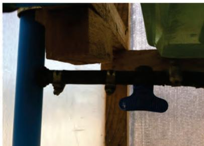
**Figura 23 y 24.** Disposición de tuberías de polietileno utilizadas para la conducción del agua hacia los emisores.
