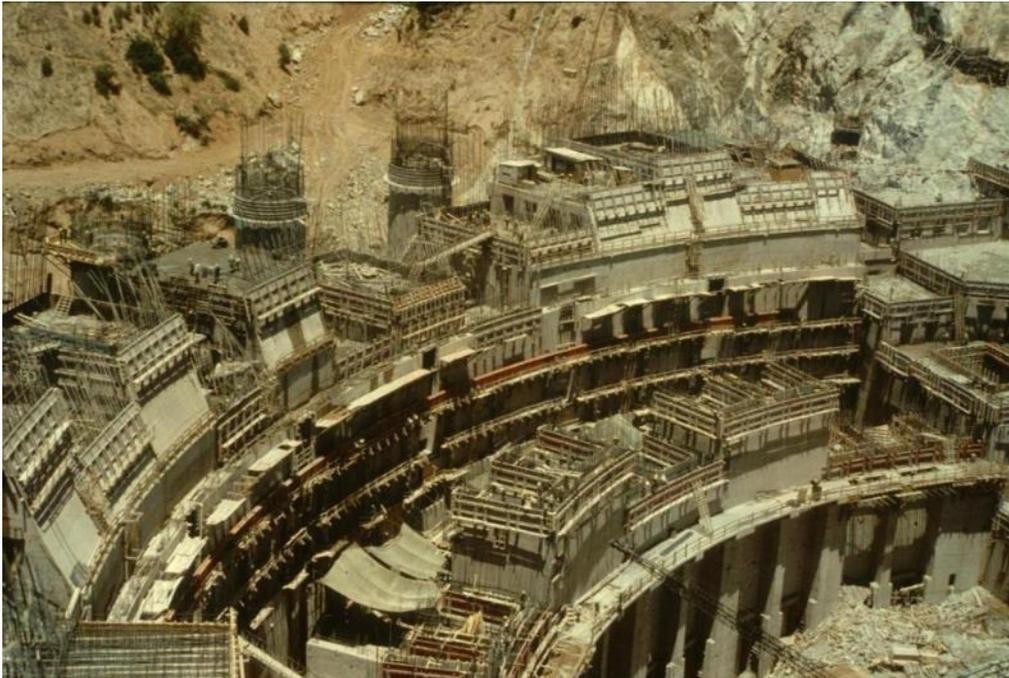
**Figura 5.4-2 Muro del Embalse Rapel en Construcción (Sep. 1965)**
