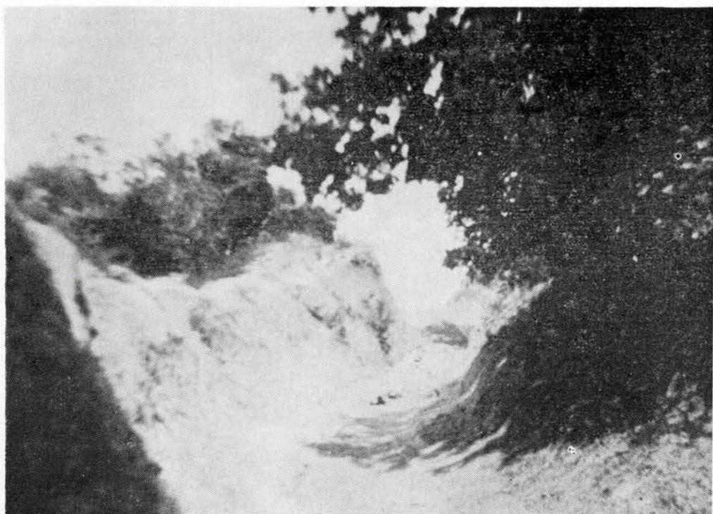
Figura 8.— Un camino de carretas, cortado hasta dos metros de profundidad dentro del granito costero meteorizado, cerca de Copiu-lemu, al noroeste de Tomeco.
