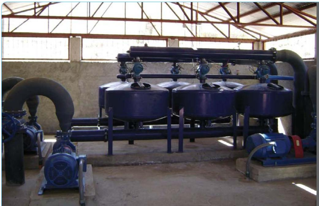
Figura 5.1 Filtros de arena en cabezal de riego por goteo
