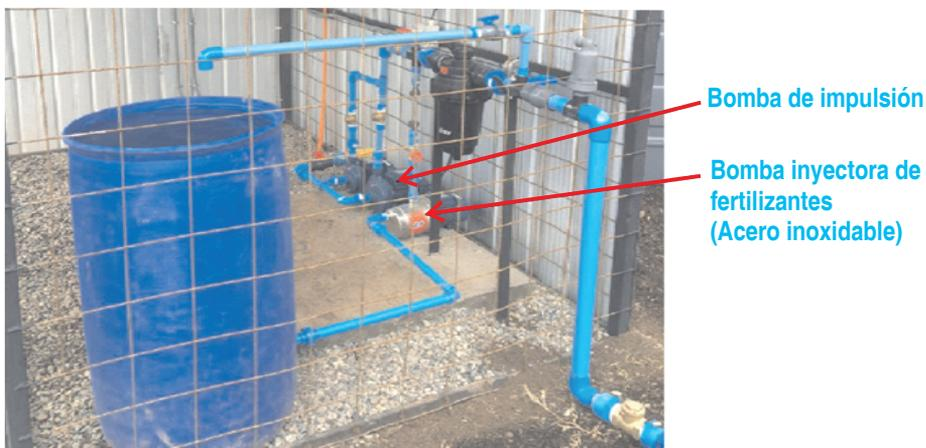
**Figura 19. Bomba de impulsión y bomba inyectora de fertilizantes**
