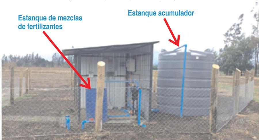
Figura 21. Estanque de mezcla de fertilizantes y estanque acumulador de agua
