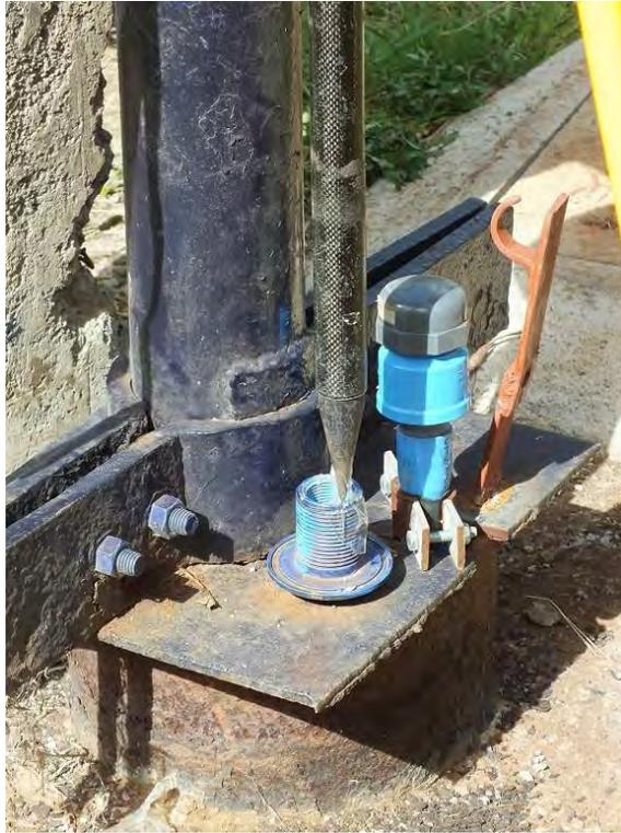
**Figura 2.3-4 detalle posición de línea de aire**
