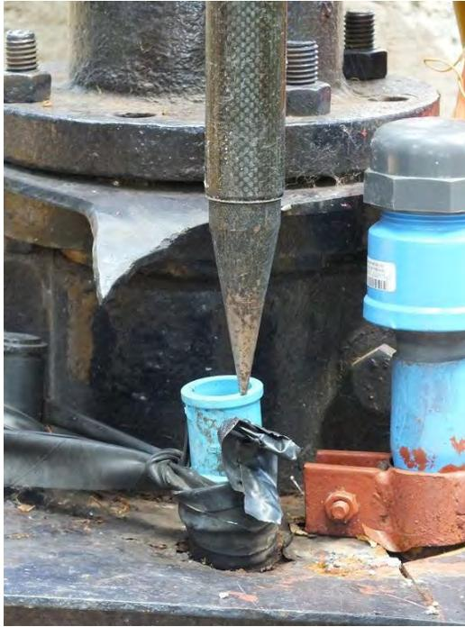
**Figura 2.2-4 Detalle de posición Línea de aire pozo 28**
