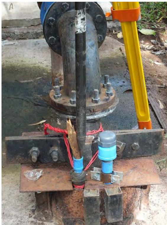
**Figura 2.12-4 detalle posición línea de aire pozo 26**
