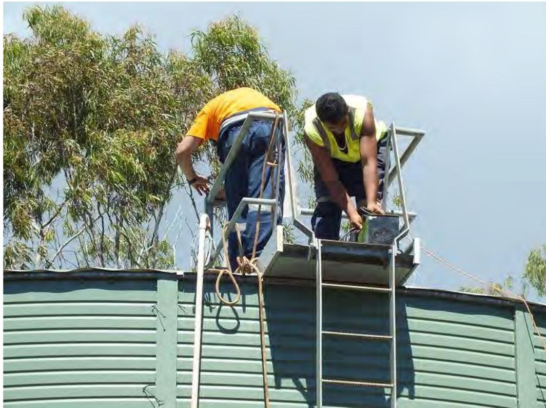
**Figura 2.1-2 soldando perno de sujeción a la baranda del estanque**
