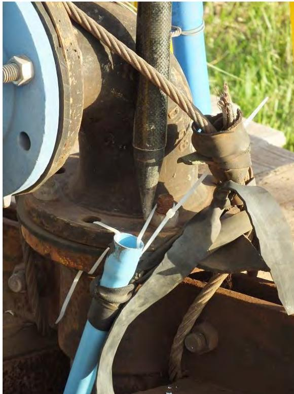
**Figura 2.5-5 detalle posición línea de aire pozo 29**
