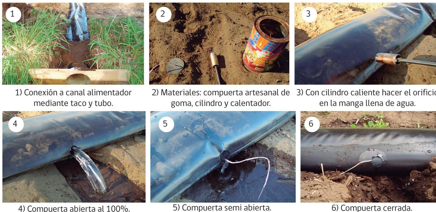
Figura 11. Instalación de una manga de polietileno con compuertas artesanales de regulación.
