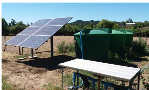
Sistema fotovoltaico para riego
