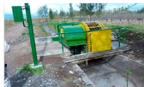
Rueda hidráulica y generador en canal de riego.
