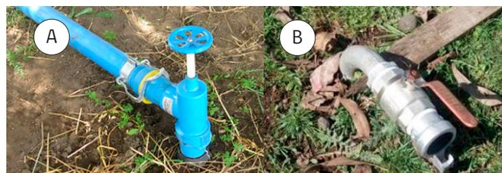
Figura 19. Tipos de hidrantes: A) hidrante de PVC y B) hidrante de aluminio.
