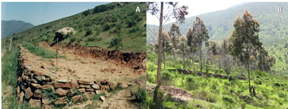
**Figura 21.** (A) Establecimiento de trinchera con muro de piedra. (B) Situación actual, 2011. Comunidad Agrícola Tunga Norte, region de Coquimbo. Fotografía: INFOR.
