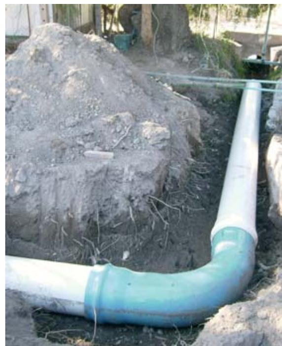
Canales de Copiapó se han entubado con tuberías de HDPE gracias a aportes de Indap. Con esta tecnología se acortan los tiempos de conducción, no se infiltra el agua y no se contamina.
