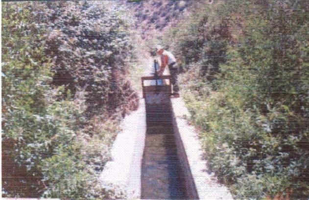
**Foto 1. Bocatoma.** Revestimiento de concreto los primeros 90 m en buen estado, así como también la compuerta metálica de acceso.
