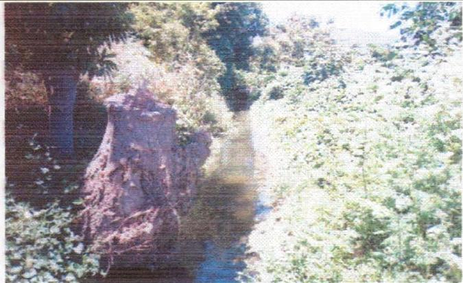
**Foto 4. Tramo revestido.** Revestimiento de hormigón, con sección rectangular luego del tramo entubado. Se producen desbordes del canal por su baja capacidad.
