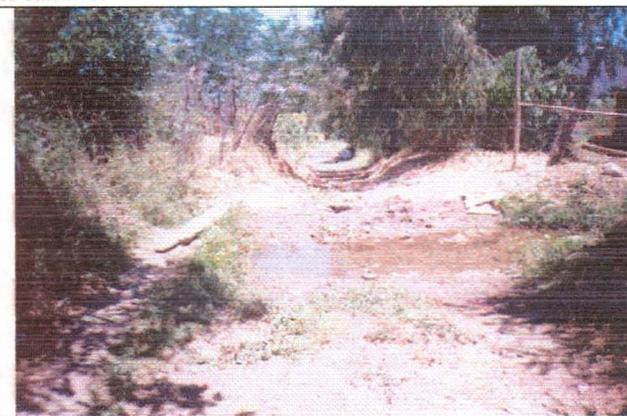
**Foto 12. Cruce Canal Derivado con Callejón Vitoco.** Se necesita alcantarilla o puente que permita el libre paso del canal bajo el camino ya que los desbordes de éste afectan al matriz que se encuentra en una cota más baja.
