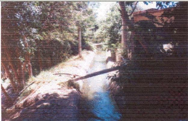
**Foto 5. Tramo Revestido.** Tramo revestido de hormigón, con sección trapezoidal, luego de tramo subdimensionado.
