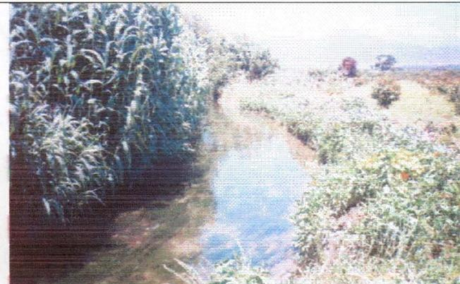
**Foto 6. Fin Tramo Revestido.** Inicio de sector con problemas de falta de uniformidad en cuanto a ancho, profundidad y pendiente y problemas de filtraciones.
