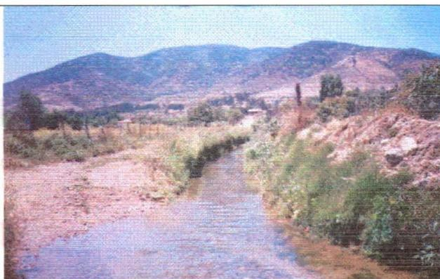
**Foto 10. Cruce Canal con Callejón El Molino.** Se necesita alcantarilla o puente que permita el libre paso del canal bajo el camino.
