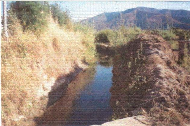
**Foto 15. Cruce Canal con Callejón Lo Tapia.** Se necesita revestimiento ya que la sección del canal es irregular
