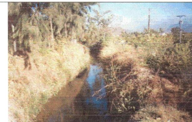
**Foto 23. Sección.** Sección irregular del canal que requiere revestimiento.
