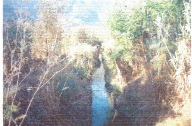
**Foto 22. Sección.** Sección irregular del canal que requiere revestimiento.
