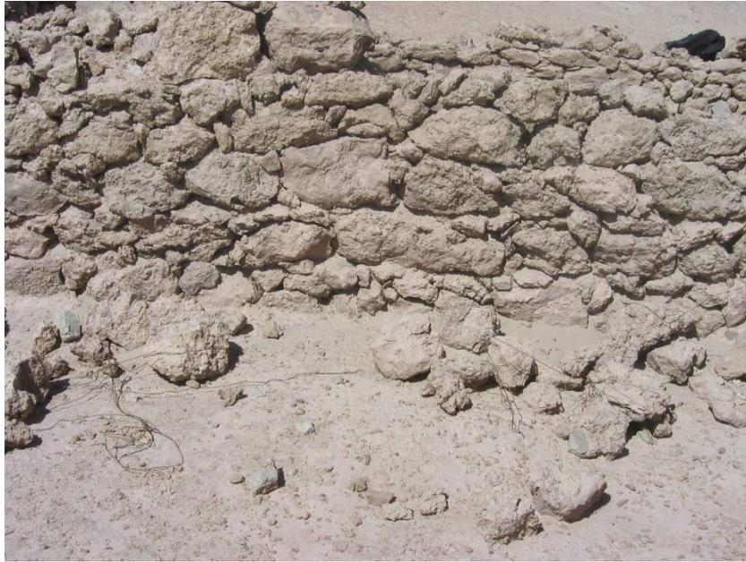
Figura 7: Detalle constructivo de muros del Recinto 1 del sitio Chuqui-2. Nótese los bloques de material calcáreo atados con alambre.
