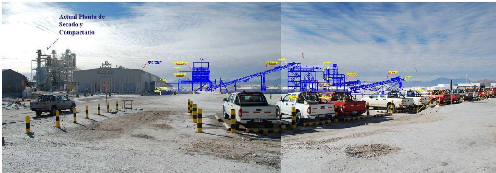
En esta fotografía se observa, de izquierda a derecha, parte de la Nave Principal de la Planta MOP-H, la actual Planta de Secado y Compactado, la bodega de producto y la nueva planta de secado proyectada, pudiéndose apreciar que las obras proyectadas son aledañas a las existentes y de una envergadura (superficie y altura) menor a las existentes.
