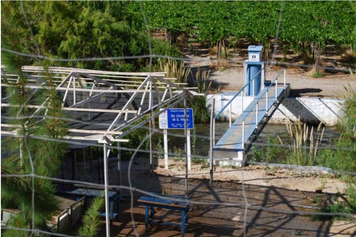
No se cuenta con la geometría exacta de la sección de la estación de aforo. Ésta se ha simulado como un canal de 30 m de longitud, con fondo en base triangular de 1,0 m de altura, con una sección superficial rectangular de 8 m de base. El material corresponde a mampostería con una rugosidad de  $n=0,020$ . Con esto se verifica si los coeficientes y regímenes supuestos en el punto anterior se ajustan adecuadamente.
