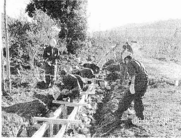
**Imagen N°5: trabajos de revestimiento del canal.**
