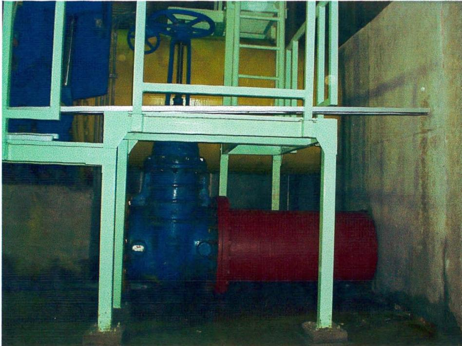
**Válvula de Compuerta de 600 mm para drenaje del Túnel**
