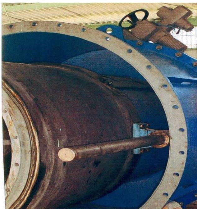
**Sistema de accionamiento de la Válvula Howell-Bunger de 1.200 mm**
