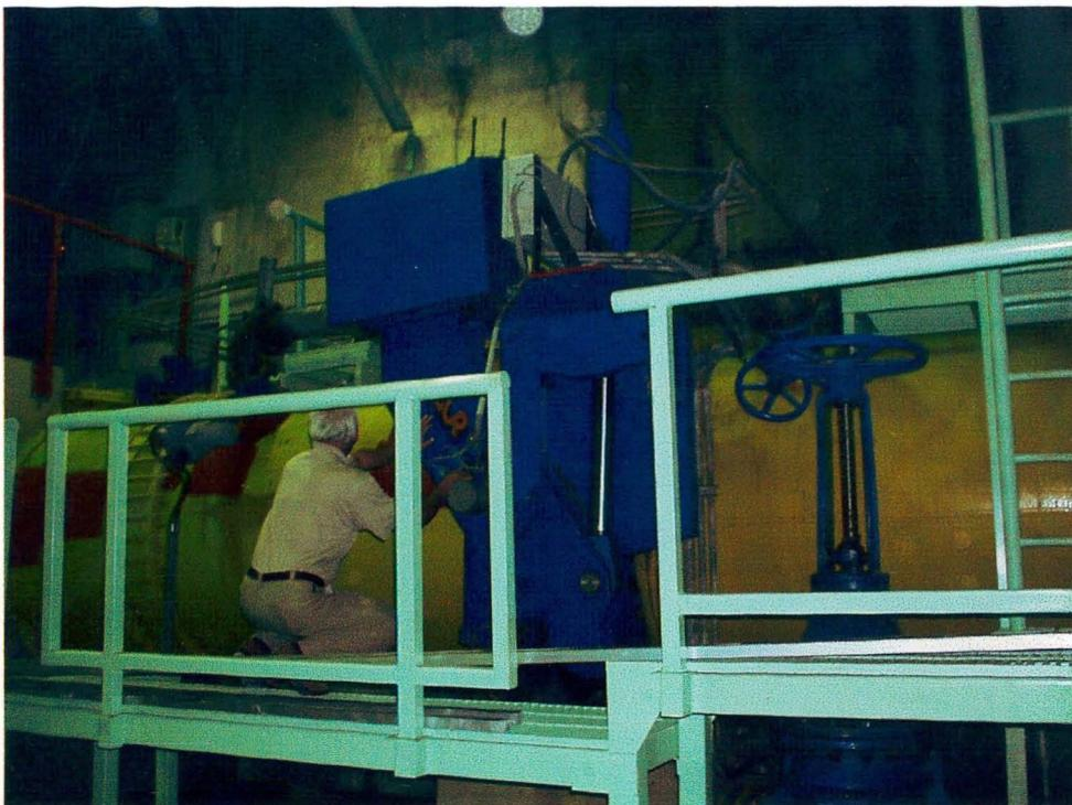
**Tubería de 1.600 mm (en amarillo), Válvula de Mariposa y sus accesorios (en azul) y pisos de reja y barandas de protección para el desplazamiento seguro del personal**
