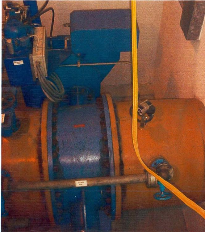
**Válvula de Mariposa de 1.200 mm (en azul), Tubería de 1.200 mm (en amarillo)
