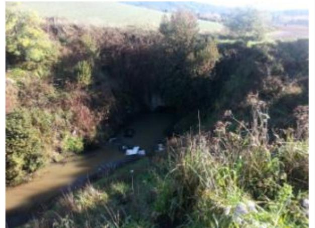
Sector Cajón. Paso la Zorra. Se aprecia abundantes desperdicios y desmoronamiento de taludes.
