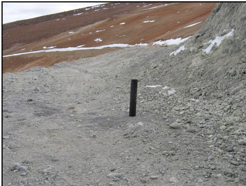
**Figura 2-5 Terminación de un pozo**
