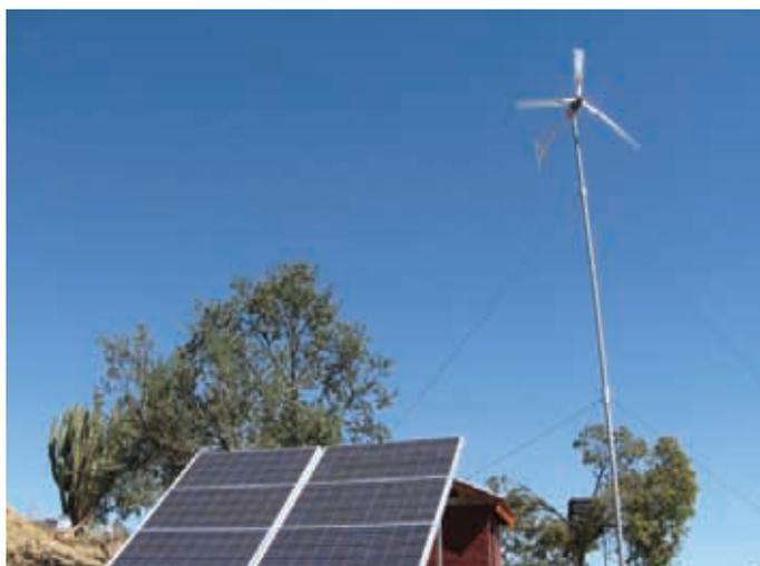
*El aerogenerador de fondo, junto a los paneles solares.*
