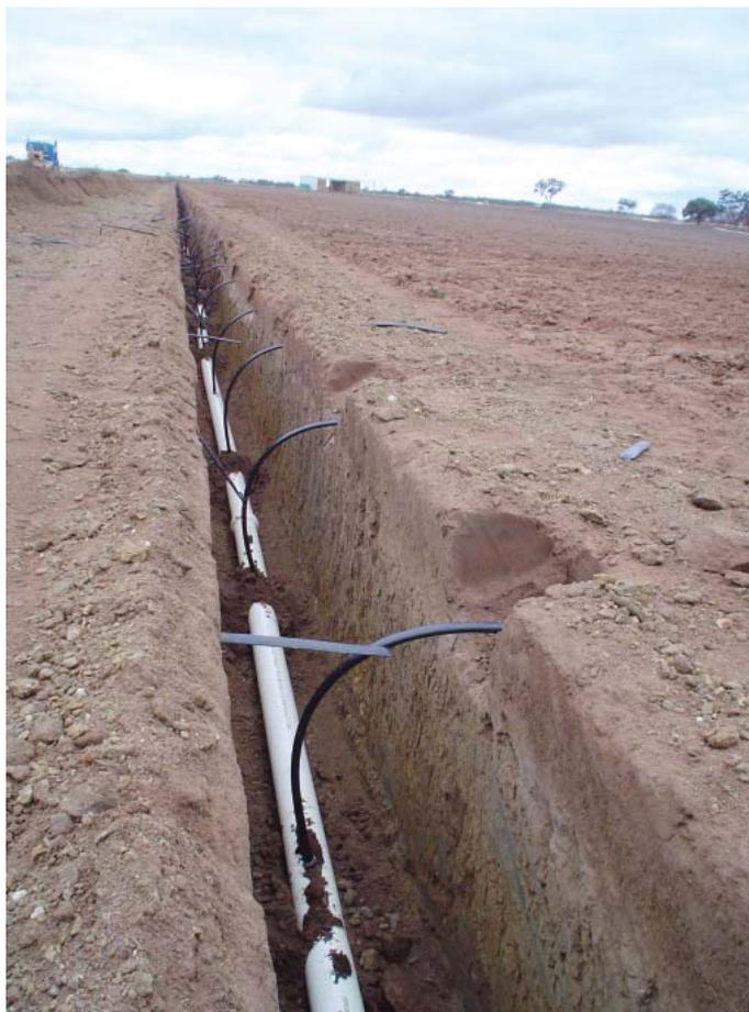
El riego por goteo sub-superficial (Sub-surface drip irrigation: SDI) o enterrado se define como la aplicación de agua bajo la superficie del suelo a través de emisores, por lo general con tasas de descarga semejantes al riego por goteo tradicional. Debido a la protección de la estructura y la aireación del suelo, el riego sub-superficial es considerado como una técnica válida para aportar agua a cultivos al aire libre. Incluso
