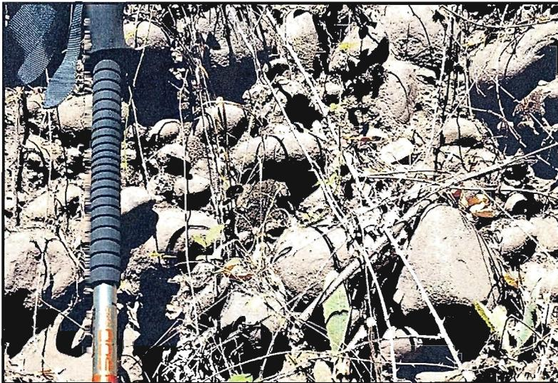
*Fotografía 18. Tarjád de pista con relleno de terraza, en la margen izquierda del eje 2.*
