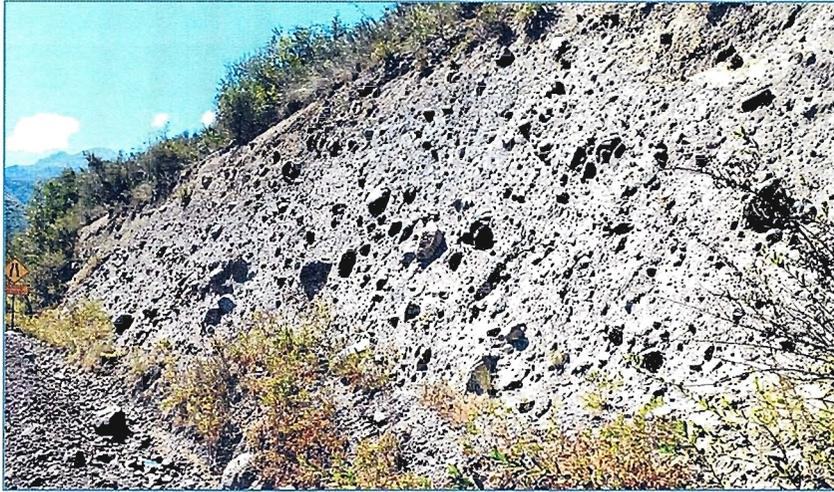
*Fotografía 24. Aspecto de un talud en materiales de avalancha volcánica. Zona de Las Leñas*
