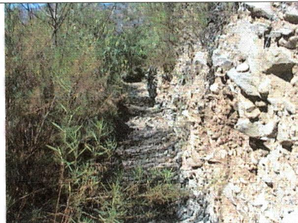
Foto N° 4: Sección sin Revestimiento Canal Las Vegas (Toma El Granado)
