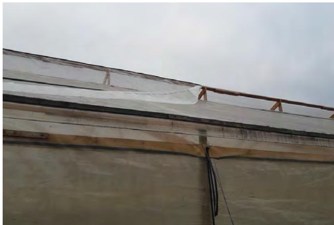
**Figura 60.** Invernaderos con ventanas y lucarnas cubiertas con mallas anti-insectos. Región de Atacama, 2018.
