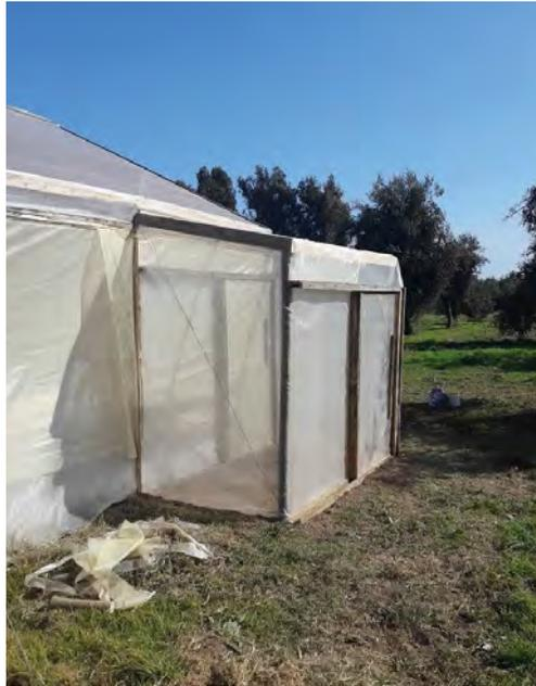
**Figura 62.** Cámara con doble puerta, siendo la externa, en este caso, de corredera. Región de Atacama, 2018.
