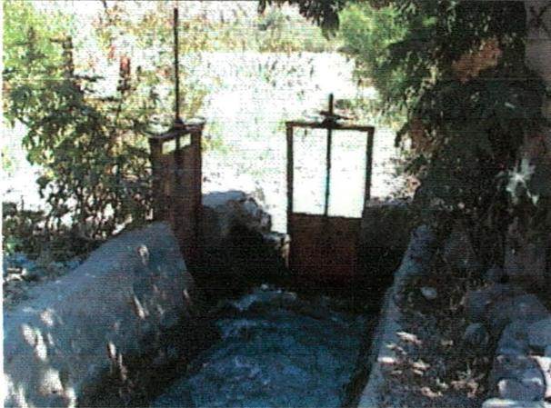
**Foto N° 7:** Compuerta de Descarga al Río Canal El Sobrante
