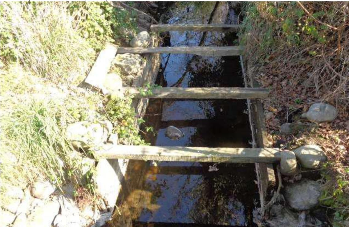
Fotografía 65. Canoa aforadora canal Zañartu poniente.
