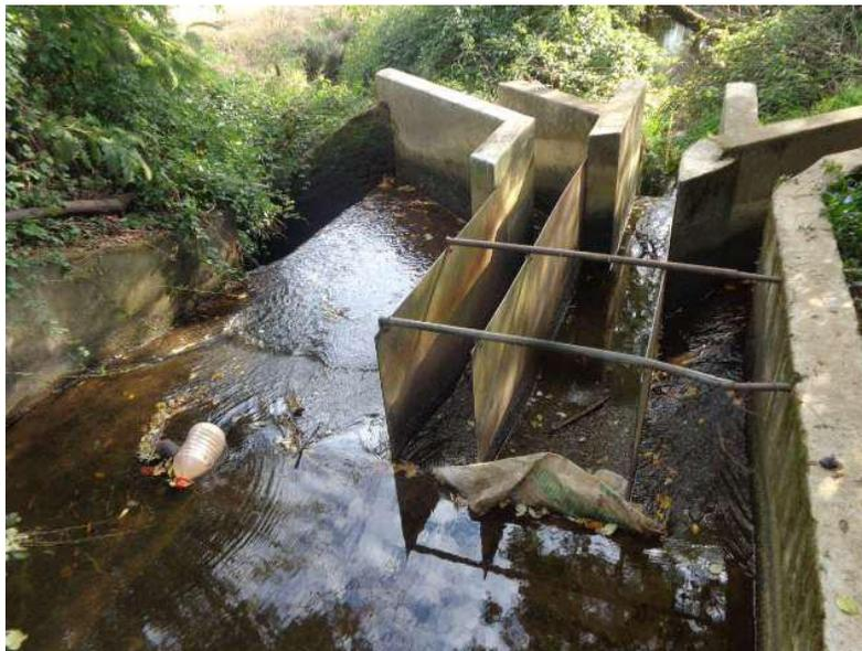
Fotografía 53. Marco partidor canal la Máquina.
