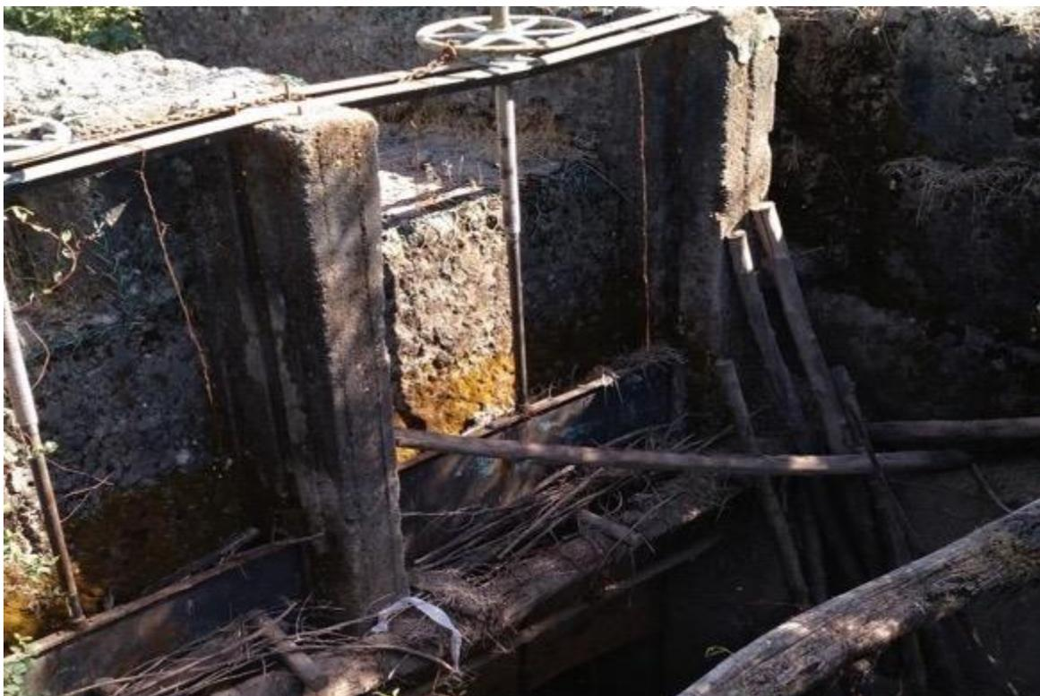
Fotografía 38. Antiguas compuertas bocatoma canal Municipal.
