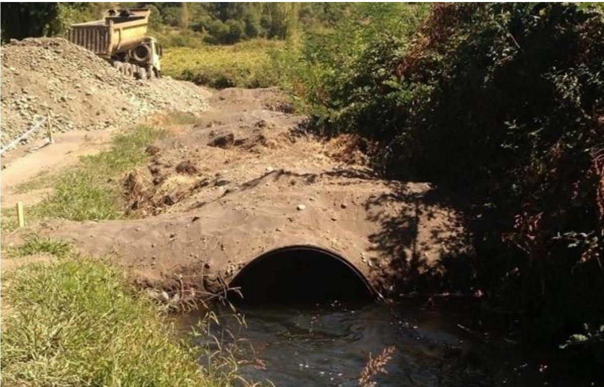
Fotografía 22. Entubamiento de canal por derrumbe de camino.
