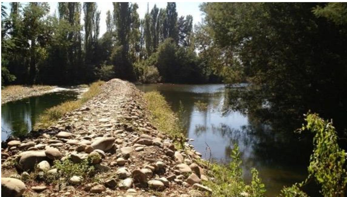
Fotografía 44. Obra de intervención del río para bocatoma.
