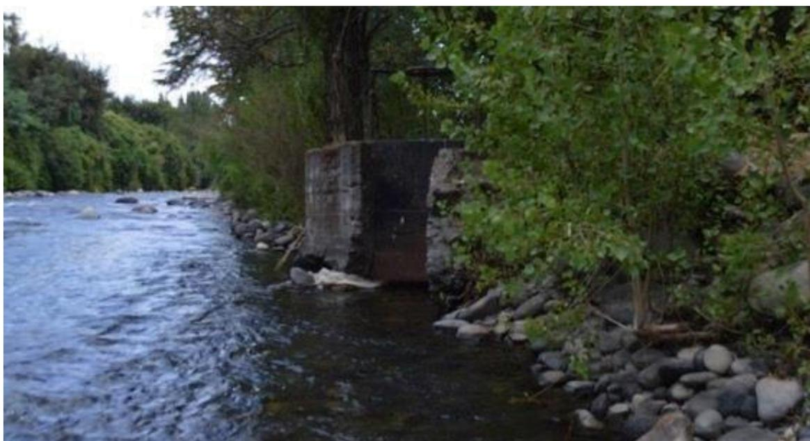
Fotografía 33. Aguas abajo bocatoma de concreto de desuso, río Chillán.
