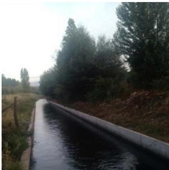
Fotografía 14. Tramo revesito del canal Arrau, río Ñuble.
