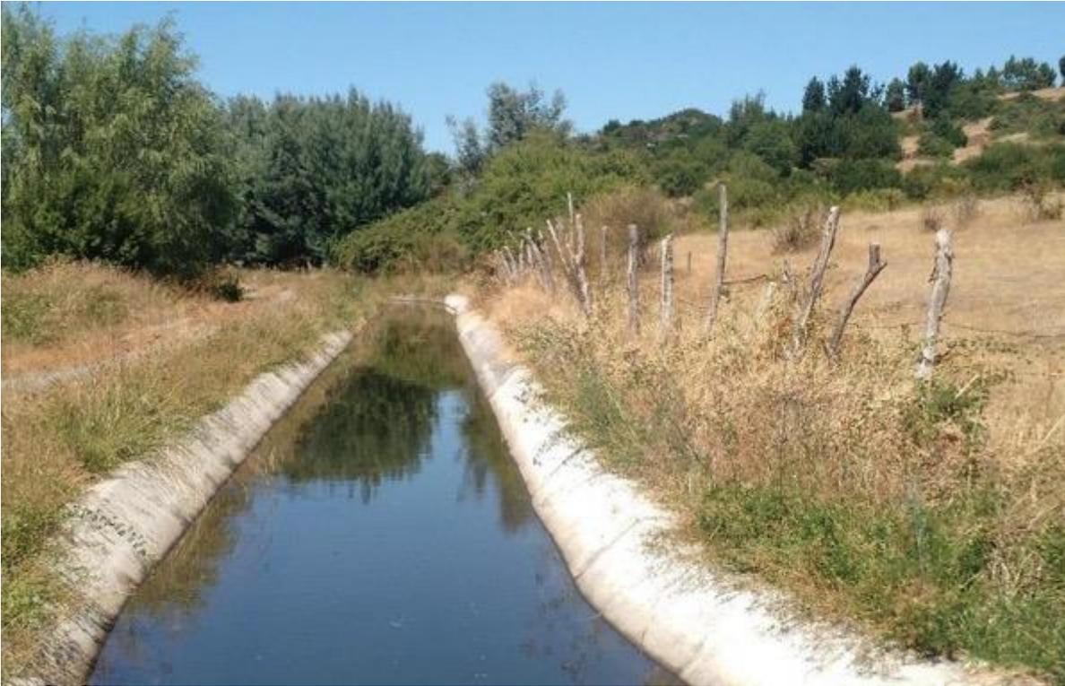
Fotografía 21. Tramo revestido de canal Quillón.
