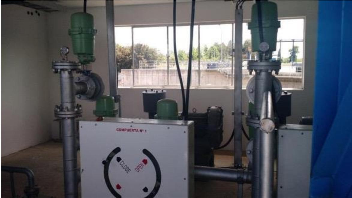
Fotografía 9. Sistema de compuertas bocatoma Laja-Diguillín.
