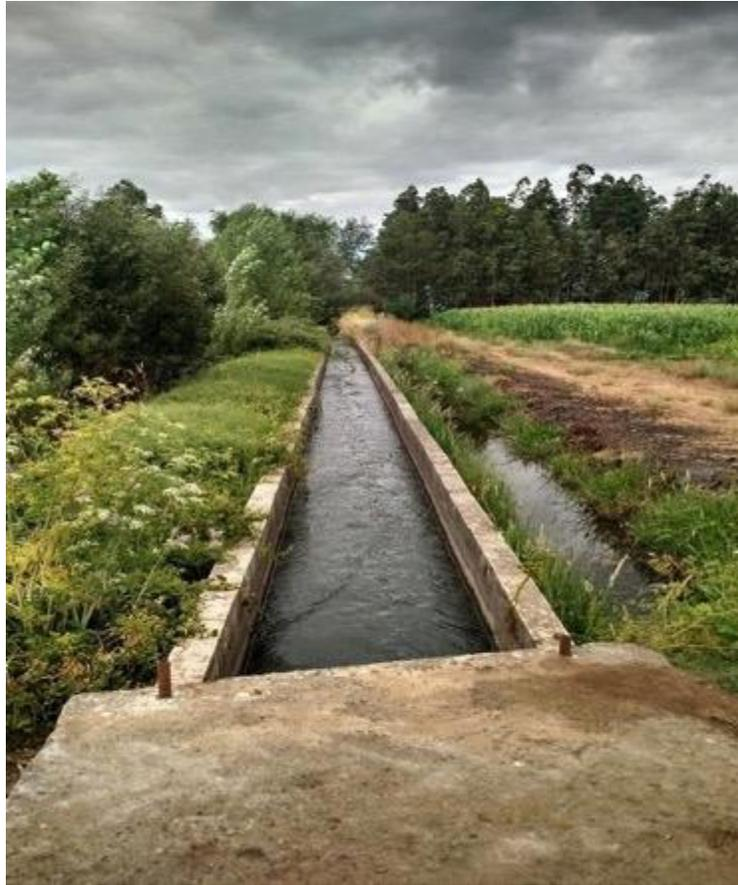
Fotografía 17. Tramo revestido canal Rinconada Cato, río Ñuble.
