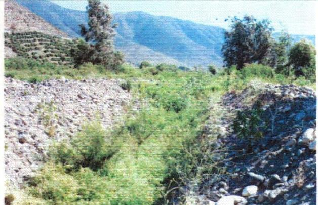
**Foto 2. Canal embancado.** Se observa que el canal no está siendo usado en este punto, con gran cantidad de vegetación.
