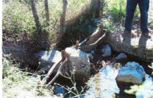
**Foto 4. Entrega a los ramales del Bajo y del Cerro.** Obra de entrega en mal estado y sin mantención.
