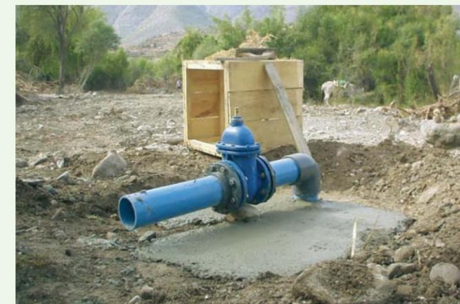
Válvula de entrega predial en construcción. Se prepara moldaje de la cámara de protección de la válvula.
