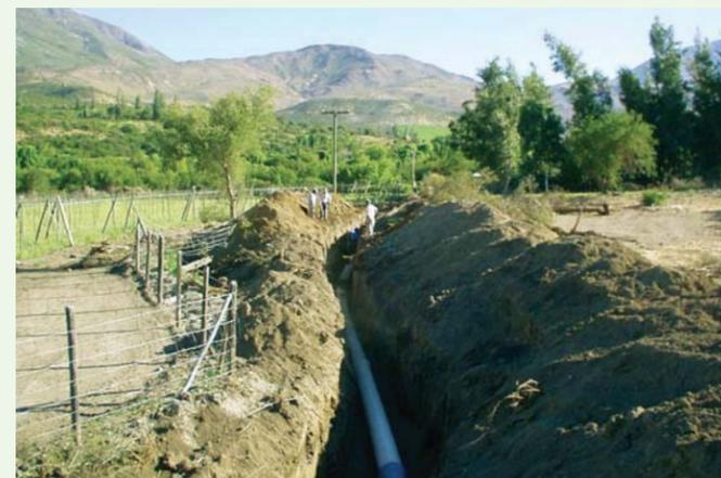
Instalación de tubería, la que quedó instalada a 80 cm. sobre la clave del tubo.
