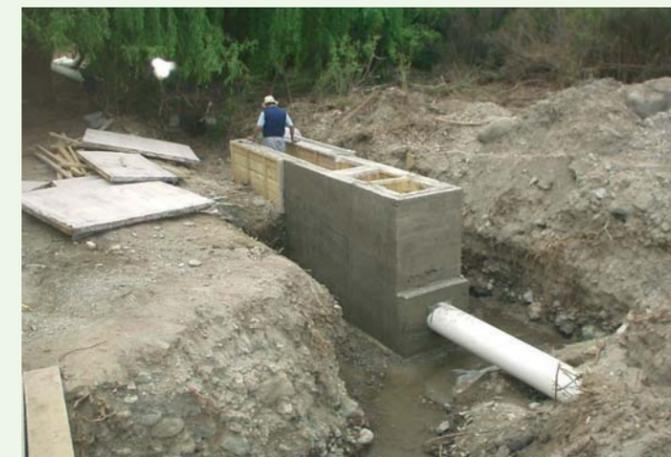
Construcción de cámara de toma, ubicada en terreno que no es afectado por crecidas del río.
