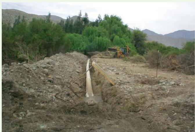
Entubamiento con una sola tubería PVC, 400 mm, clase 2,5.
