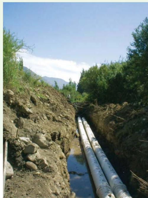
Entubamiento en doble tubería, PVC, 400 mm, clase 2,5.
