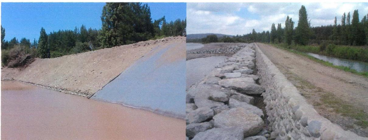
**Figura 23.** Imagen izquierda, revestimiento con GEOTEXTIL del talud externo del terraplén. Coordenadas UTM E: 731708, N: 5838186. Imagen derecha, Protección con muro de mampostería, y espigones de enrocado ubicados en riera del río Bio Bio. Coordenadas UTM E: 731517, N: 5838348.
