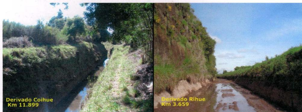
**Figura 3.** Imagen izquierda, derivado Coihue con cota de fondo 7 metros bajo cota de terreno. Imagen derecha, derivado Rihue con taludes verticales.
