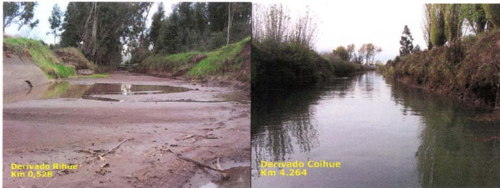
**Figura 1.** Imagen izquierda, derivado Rihue con sedimentación de 80 centímetros, el revestimiento para evitar la entrada de sedimentos es incapaz de contener los grandes volúmenes que ingresan. Imagen derecha, derivado Coihue más de un metro de profundidad.
