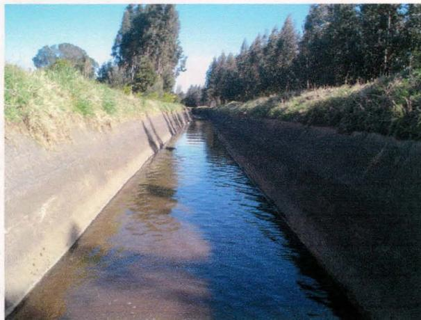
**Figura 35.** Derivado Coihue revestido, disminuye pérdidas por filtración.
