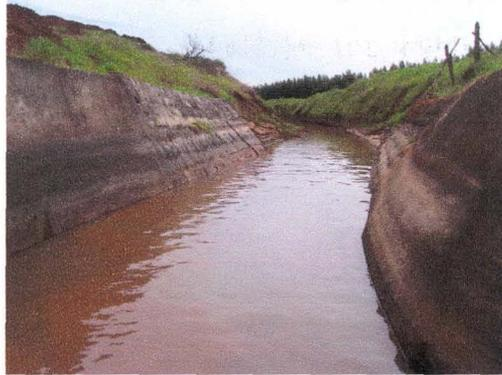
**Figura 38.** Derivado Rihue a la salida del sifón. Problemas de erosión del terraplén derecho. Coordenadas UTM E: 722554, N: 5836513.
