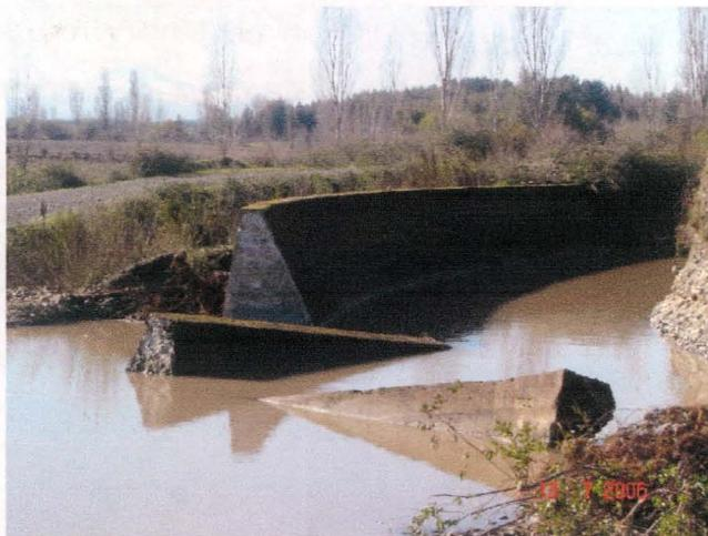
**Figura 25.** Muro de contención del canal Matriz, destruido por el temporal del 11 de julio del 2006. Coordenadas UTM E: 728933, N: 5838292.
