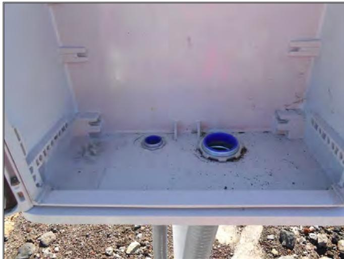
**Fig. 3.2.3-E. Caja para data logger y terminales de tubos flexibles.**
