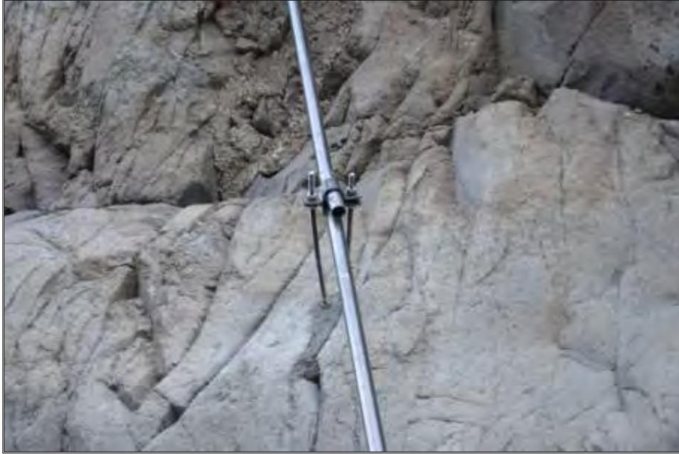
**Fig. 3.2.2.1-F. Tubería de protección del cable del sensor de presión.**
