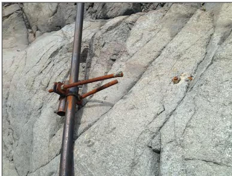
**Fig. 3.2.2.2-B. Anclajes cortados del tubo protector para el cable del sensor.**
