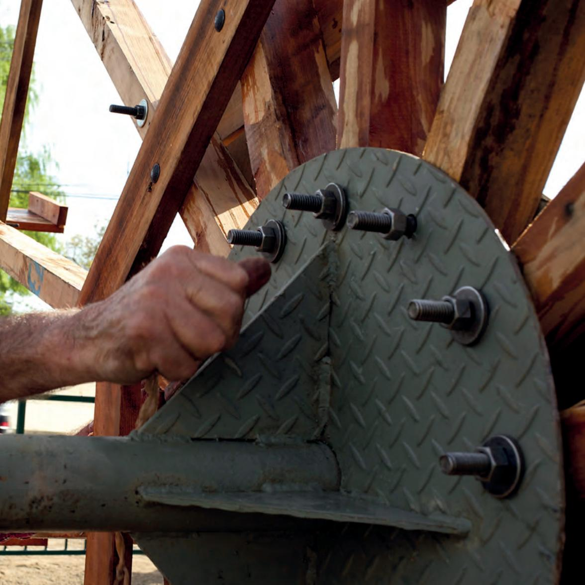
Arturo de Jesús Lucero Zamorano es constructor y reparador de las ruedas de agua de Larmahue, también conocidas como azudas. Estas colosales estructuras de madera forman un sistema de regadío, mediante un mecanismo de extracción de agua de canal y su distribución para los cultivos, basado en el uso y cuidado del recurso hídrico.
